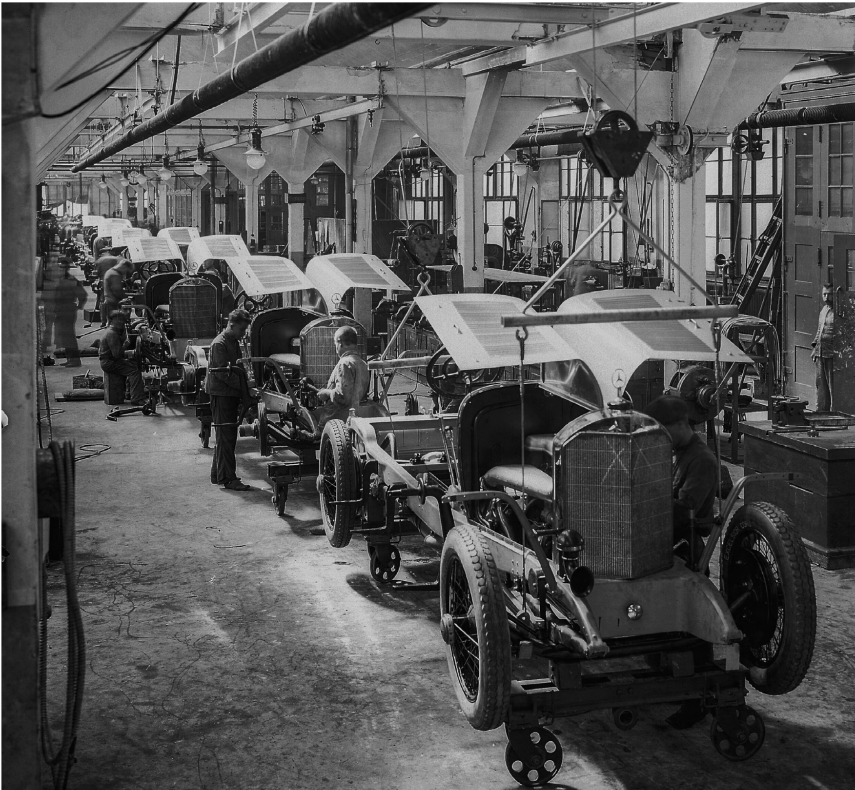
Mit der Chassis-Montage war das Rahmenfahrzeug fahrfertig, ohne Karosserie.
